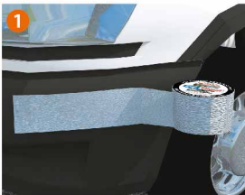
Réparations de tampon
