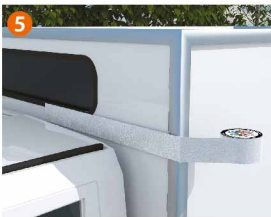
Réparations de bords de fenêtre
