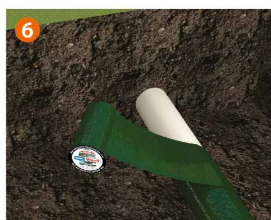
Protections de tuyaux souterraines
