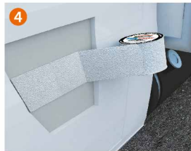
Protections et réparations à l'intérieur de la porte
