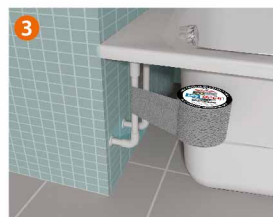
Protection de tuyaux d'eau contre la rouille
