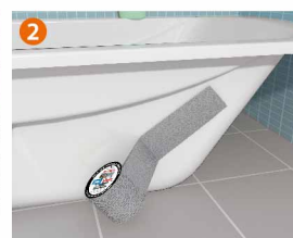
Réparations de cuvette
