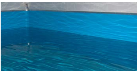
İçme Suyu Deposu
