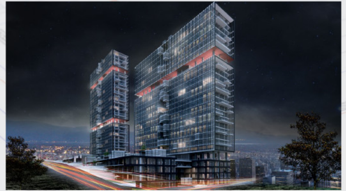
NDL Cubes Nuhoğlu İnşaat Projesi / Ankara 15.000 m 2
