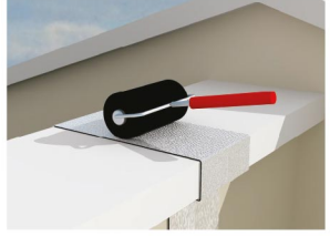
Yapıştırdıktan sonra iyice bastırın
