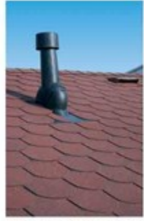
Tesisat havalandırma bacası
